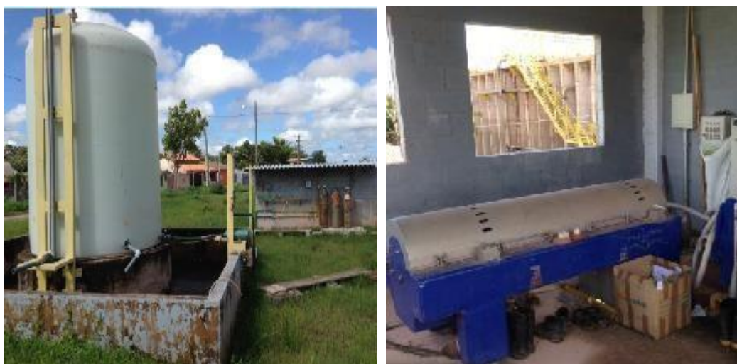
Figura 4.13 – Sistema de desinfecção por cloro e centrífuga para desaguamento de lodos
