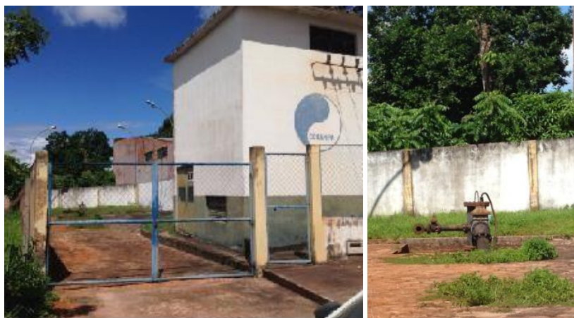
Figura 2.12 – Elcione Barbalho - Poço 02, RAP e Elevatória
