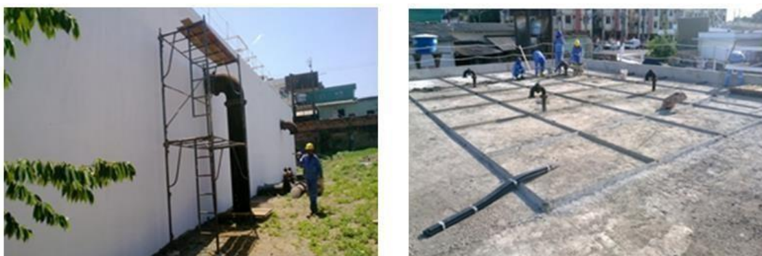
Figura 3.5 - Obras executadas no CRD-Centro, do PAC I, pintura e juntas da laje do RAP
