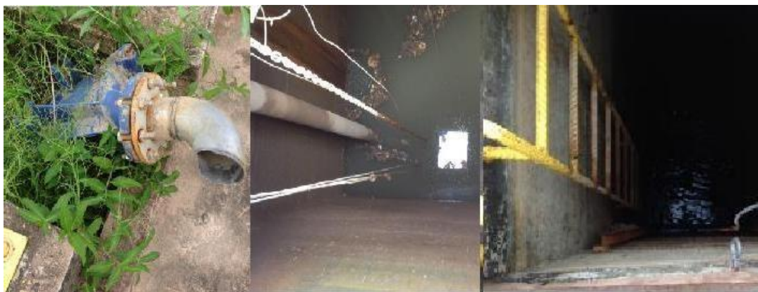
Figura 5.2 – ETE Urumari – Saída da bomba submersa quebrada por falha de projeto, no poço de entrada e equipamento de retirada da bomba. Também cesto não adequado
