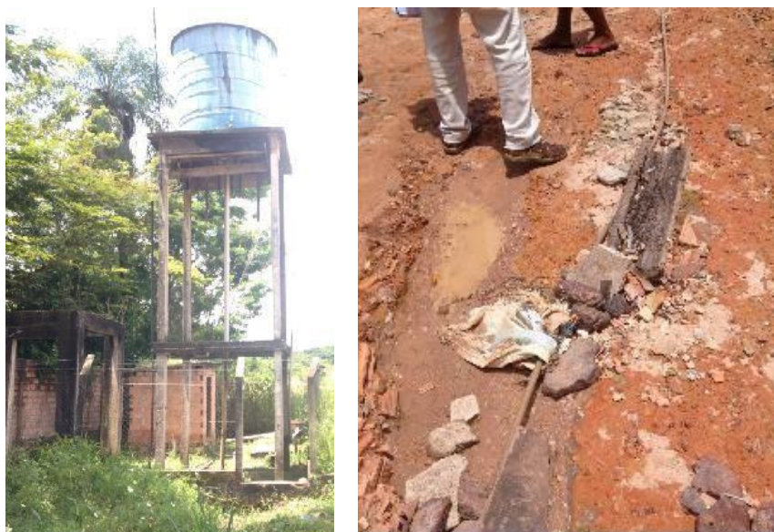
Figura 2.38 – Poço, Caixa d'água e ramal sem cobertura (rua com erosões severas)
