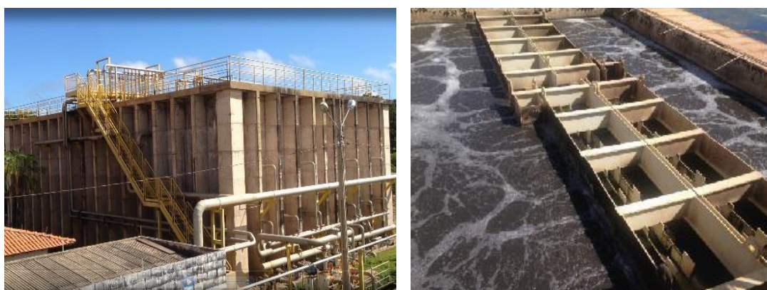
Figura 4.11 –.Módulos U-Box e vista superior do reator aeróbio
