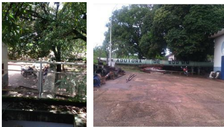
Figura 2.23 – Adutoras de 800 mm na saída do Complexo Irurá
