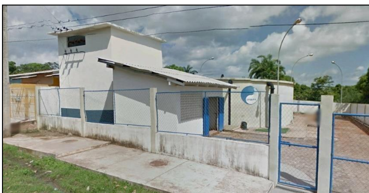
Figura 2.47 - Poço Elcione 02, Subestação, EAT e RAP de 300 m 3 – Travessa B
