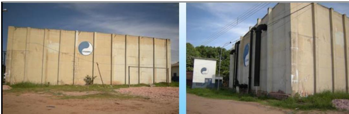
Figura 2.48 - Conquista: RAP 3.000 m 3 / Subestação existente e RAP
