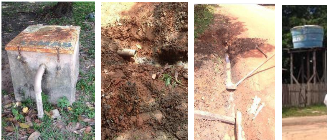
Figura 2.39 – Poço, reparo na rede bastante superficial e caixa d'água do microssistema
