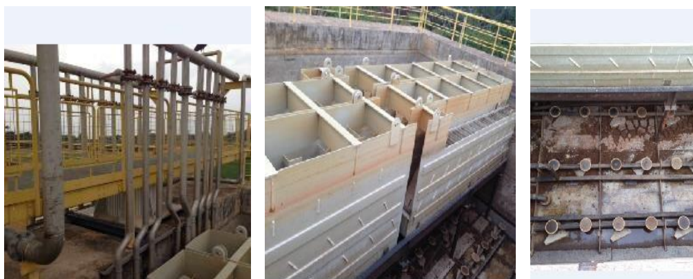
Figura 4.18 – Tubulações de ar para o processo aeróbio e sistema aeróbio antes do enchimento, com detalhe dos injetores de ar.
