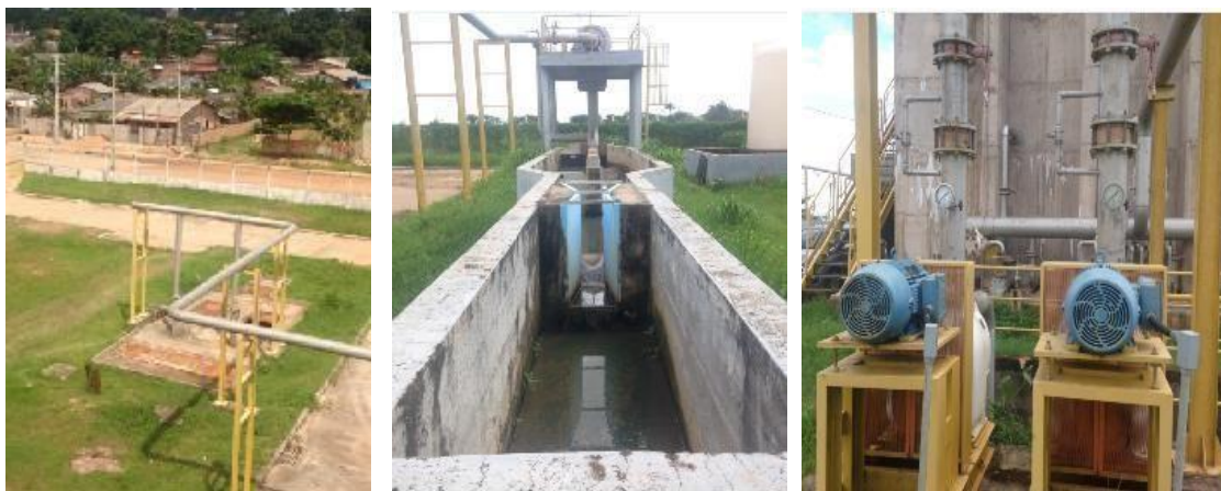
Figura 4.18 – Tubulações de ar para o processo aeróbio e sistema aeróbio antes do enchimento, com detalhe dos injetores de ar.
