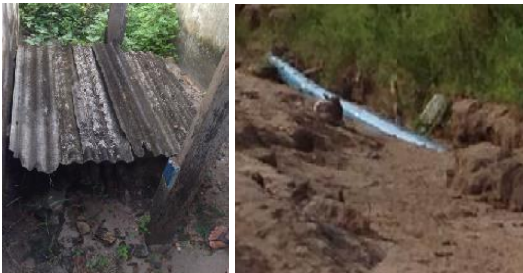
Figura 2.44 – Microssistema Maicá: detalhe do poço e tubulação da COSANPA, instalada e sem uso ainda, apresentando rua bastante erodida e tubulação exposta.
