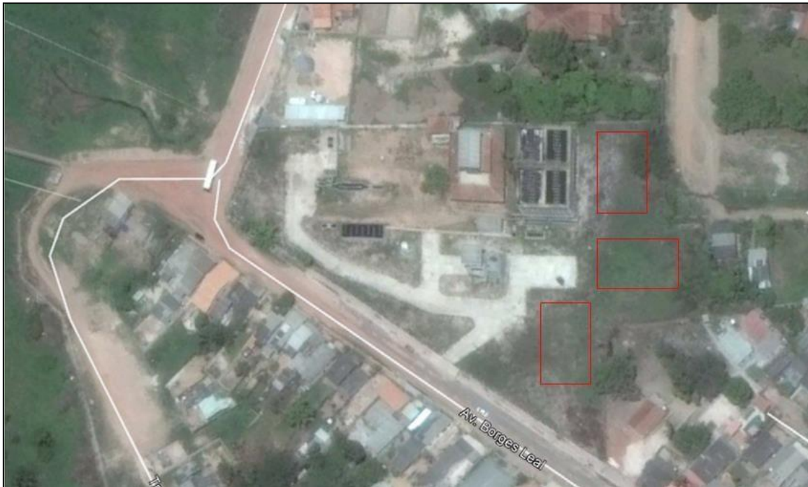
Figura 4.7 – Vista aérea do bairro Mapiri e ETE Irurá
