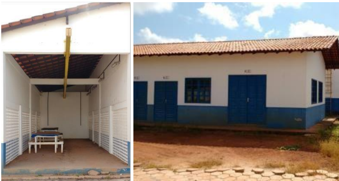
Figura 2.21– Setor Livramento– Casade cloração e casa de química - obras paralisadas
